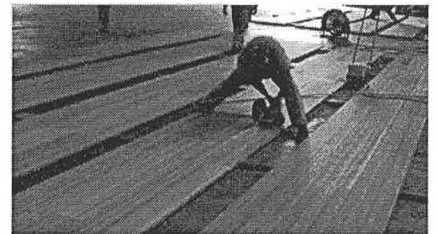
竹合板の仕上作業
