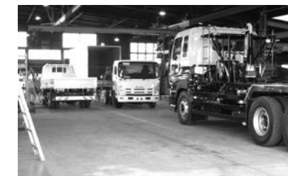
今年は38度超えの猛暑に見舞われた群馬県。工場天井にルーファンを新しく設置して乗り切った。
