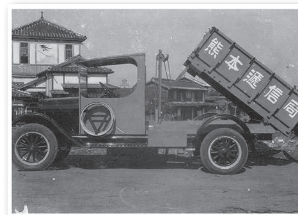
大正9年に開発された矢野式機械式ダンプボデー
