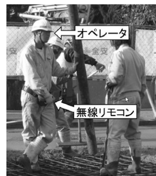
写真2 打設作業
