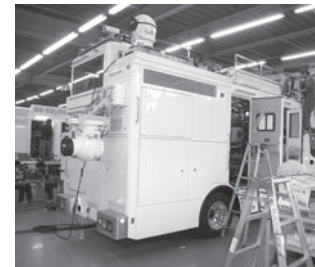
可動操作可能カメラの設置作業
