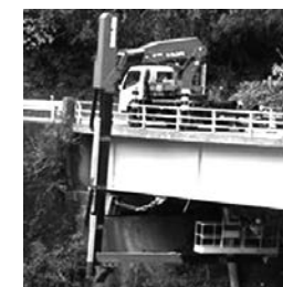
橋梁点検車による点検
