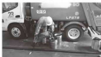
②油圧装置 작동油抜き
