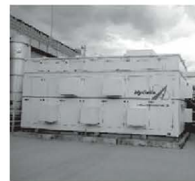
水処理センター 水素製造装置
