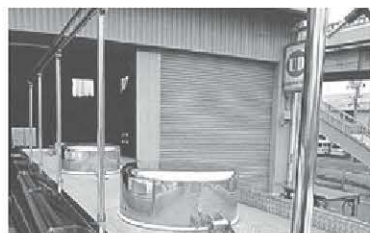
屋根上作業中の落下事故を防止する「立ち上がり式手すり」
