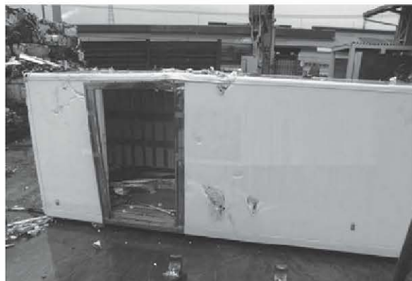
パンボデー解体状態
