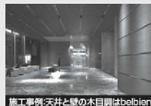
施工事例:天井と壁の木目調はbelbien
