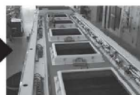
電気配線の設置
