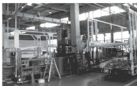
完成・電気工程
