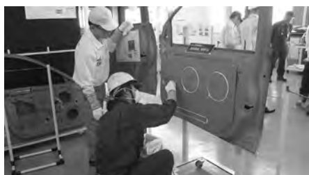
シーリングの研修
