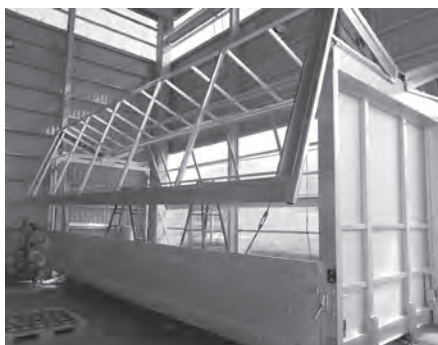
ウイングボデーの製造工程
