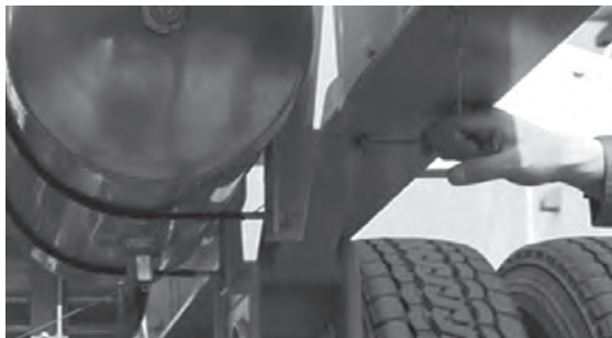
1日1回タンク内の凝水を排出してください。
