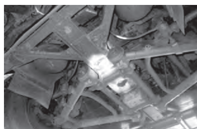
バス専用リフトでリフトアップして、下から腐食部分を目視で確認する
