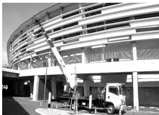
図1 AT-320XTG作業風景
