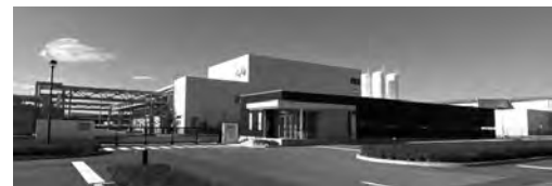
水素製造装置棟(奥は貯蔵棟)
