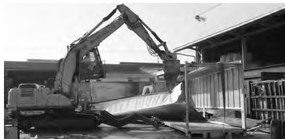
大型重機・ニブラによるバンボデー解体
