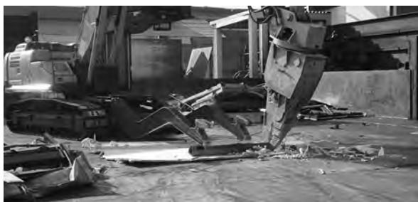
自作の工具で断熱材を削ぎ落とし
