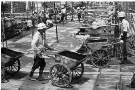
人力によるコンクリート打設の様子
