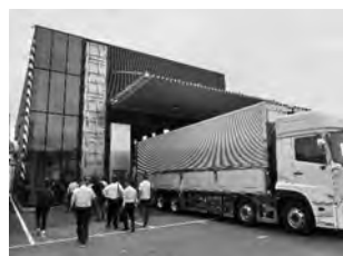
竣工された第二工場
