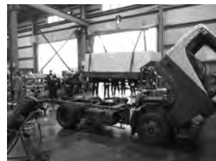
衛生車の解体作業
