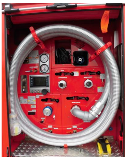
ポンプ室側板
