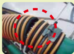
吸引ホース折損
