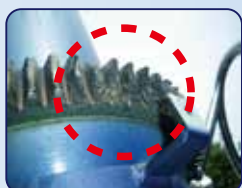
旋回ギヤ摩耗・破損
