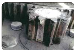
旋回台ギヤ破損
